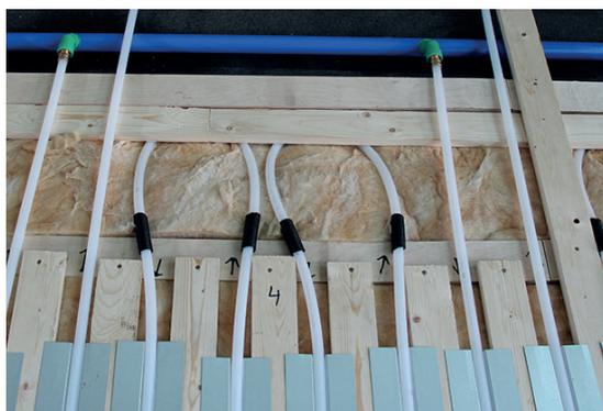
**Hohe Sicherheit** Bei ATHE-OlympicS H-Swing IN kommt das ATHE-Middle Fünffachverbundrohr im Maß 18x2 mm zum Einsatz. Das Rohr ist DIN-geprüft und steht so für maximale Sicherheit und Langlebigkeit.
