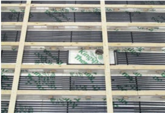
**Schnell verlegt** Die vorgefertigten H-Module werden zeitsparend auf der bauseitigen Dämmung ausgelegt. Dank der flexiblen Konstruktion kann auch auf Besonderheiten wie Bodenauslässe souverän reagiert werden.
