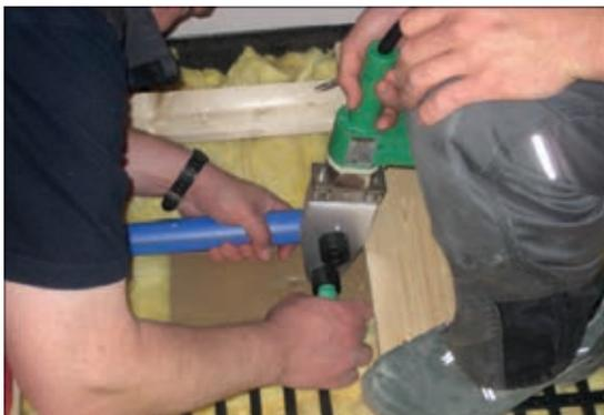
**Sicher verbunden** Mittels Heizelementmuffenschweißung werden die Module dauerhaft miteinander verbunden.
