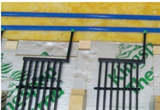
**Schnelle Anbindung** Die Module werden an den Tichelmannverteiler angeschlossen.
