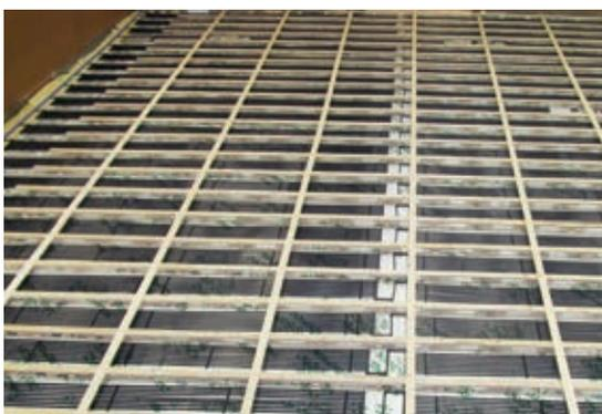
**Bei Testbeginn** Dank der engen Verlegung kann das System äußerst energieeffizient arbeiten. Die Verlegung unterhalb des Blindbodens ist zudem sehr platzsparend.
