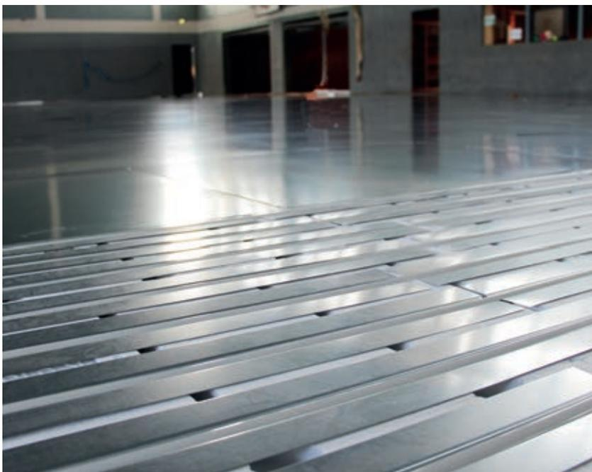
**ATHE-OlympicS Flex** Zur optimalen Wärmeverteilung Leistungsentfaltung wird auf dem System Flex vollflächig ein Wärmeleitblech aufgelegt.
