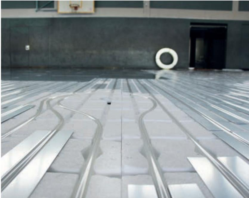
**ATHE-OlympicS Flex** In die zuvor verlegten Systemplatten werden die Wärmeleitbleche eingelegt. Sie nehmen anschließend das Heizrohr auf und halten es sicher fest. Auf bauliche Gegebenheiten wie z.B. Bodentanks kann flexibel Rücksicht genommen werden.
