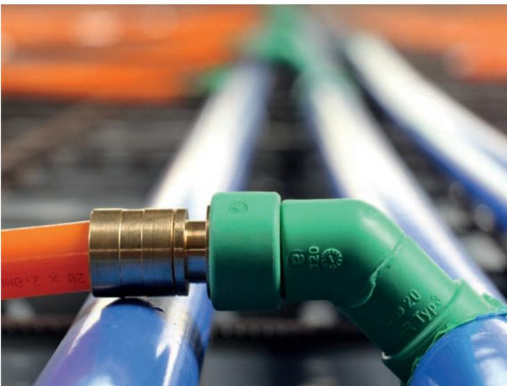
**Hochqualitativ** Mittels unlösbarer Verbindungstechnik wird das Rohr am Ende eines Heizkreises an den Verteiler (hier Tichelmann) angebunden. Die Verbindung ist dauerhaft und zertifiziert.
