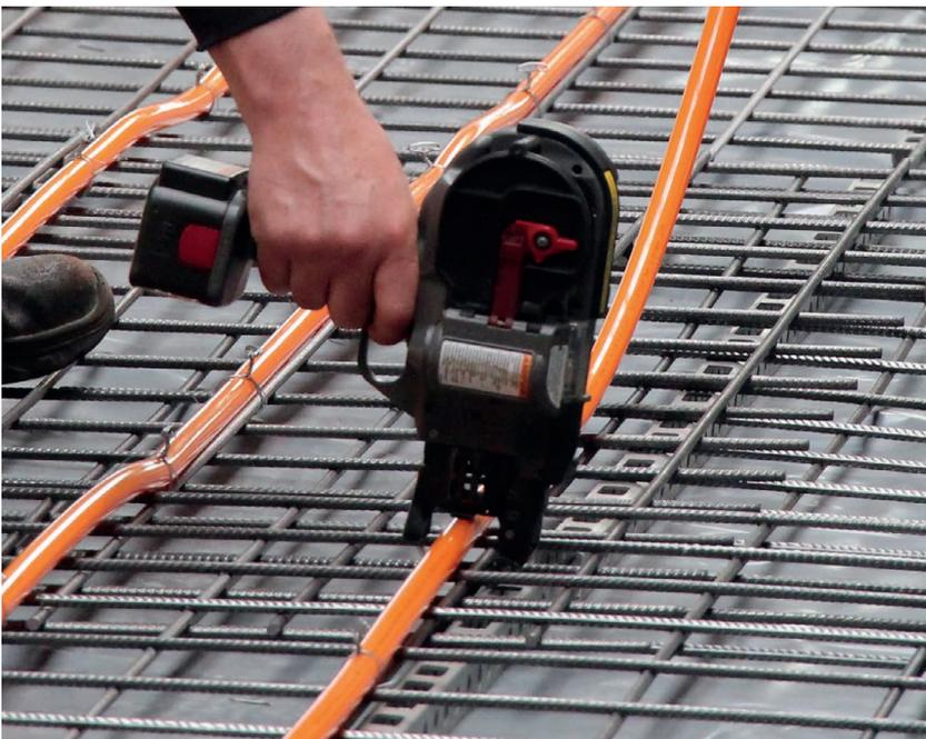
**Sicher verbunden** Mittels einer Rödelsmaschine wird das Rohr auf der bauseitigen, aufgeständerten Baustahlmatte befestigt.
