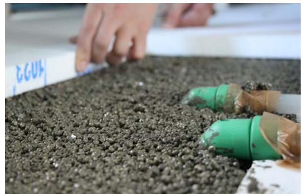
Rohre und Leitungen werden vollständig und sicher umschlossen. Auf der Schicht T.T. Dämm Light kann anschließend fachgerecht die Dämmung verlegt werden.
