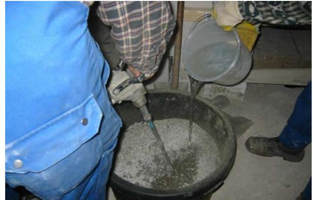
T.T. Dämm Light wird direkt auf der Baustelle in der jeweils benötigten Menge angemischt. Durch die Abfüllung in 8kg Säcken kann unnötig hoher Verbrauch vermieden werden.
