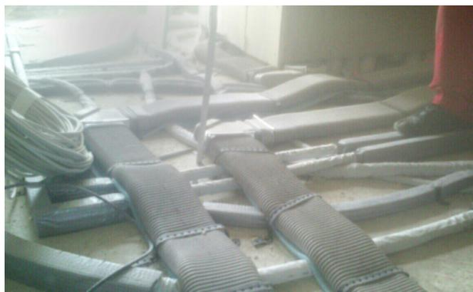
**1** Bei vielen Bauvorhaben ist eine fachgerechte Ausbringung der Dämmung aufgrund der Rohr- und Leitungsstruktur nicht mehr möglich.
